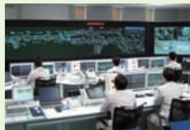
相模鉄道総合列車運行管理システム (TTCシステム) Total Traffic Control System (TTC System) for Sagami Railway
