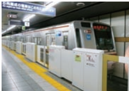
東京メトロ有楽町線可動式ホーム柵、可動ステップ Partial-height platform screen doors and movable steps for the Tokyo Metro Yurakucho Line
